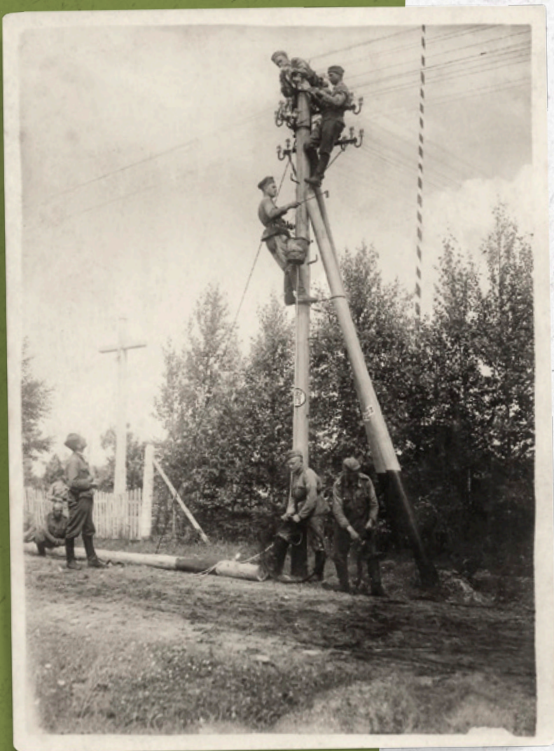
Prace przy budowie linii telefonicznej na odcinku Batalionu KOP Krasne, 1935 r.
