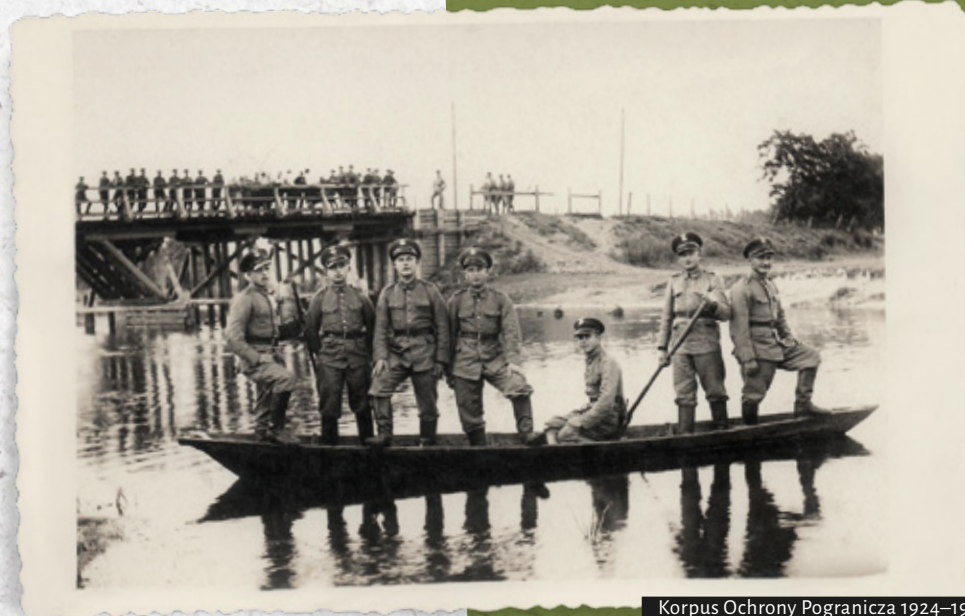
Saperzy KOP podczas budowy lub remontu mostu na pograniczu. Lata trzydzieste
