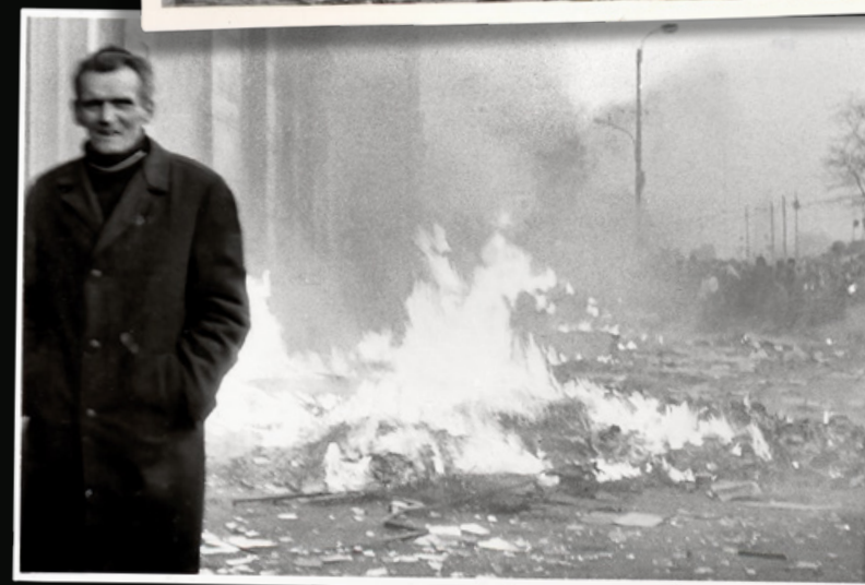
Płonący gmach KW PZPR w Szczecinie, 17 grudnia 1970 r. (AIPN Sz)
